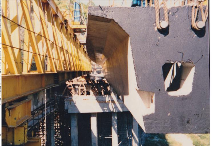
La Samer produce travi da ponte in cemento armato precompresso dal 1981. Le travi sono realizzate in calcestruzzo di elevata resistenza con armatura aderente pretesa formata da trefoli di acciaio armonico.
